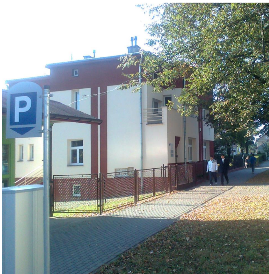
Fot. 16 Dom Buhlów stan w roku 2010
