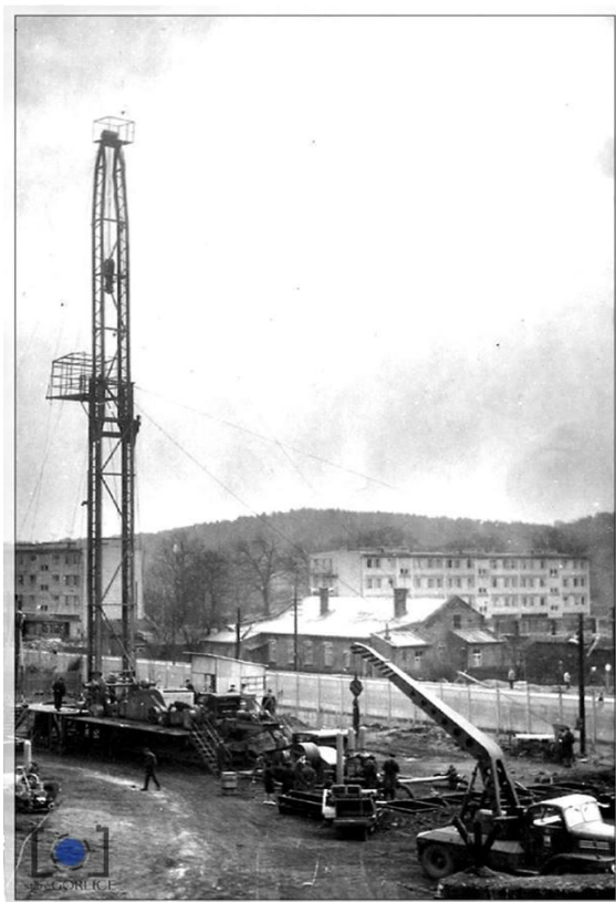
Fot. 7 Stawianie prototypu urządzenia wiertniczego lata 60-te (ze zbiorów MBP w Gorlicach).
