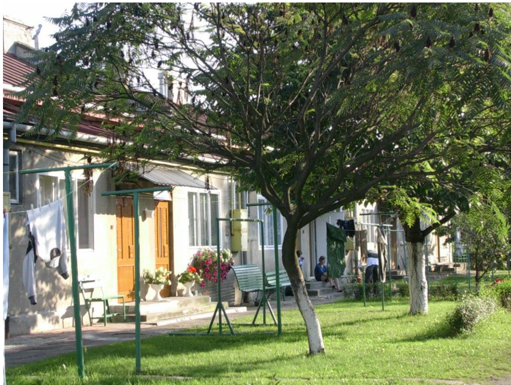
Fot. 37 Typowy parterowy dom mieszkalny na kolonii – stan obecny
