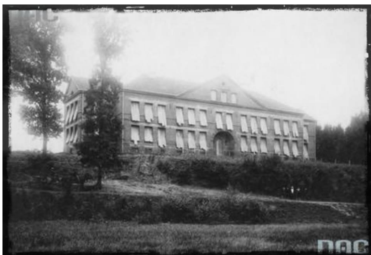
Fot. 25 Szkoła podstawowa nr 3 w budowie
