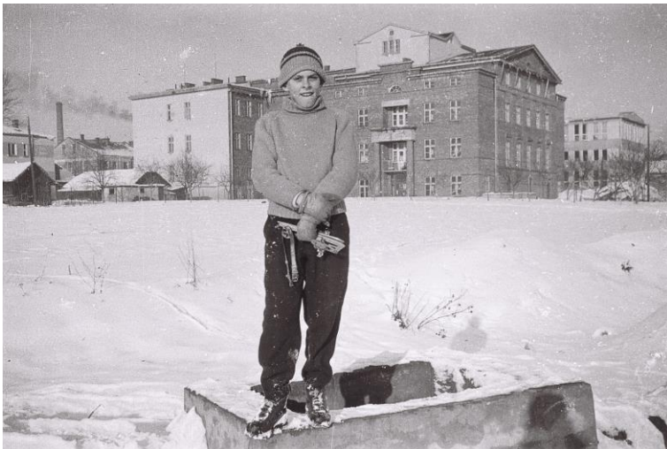
Fot. 11 Leszek Stolarz na tle Domu Kultury II połowa lat 50 tych.
