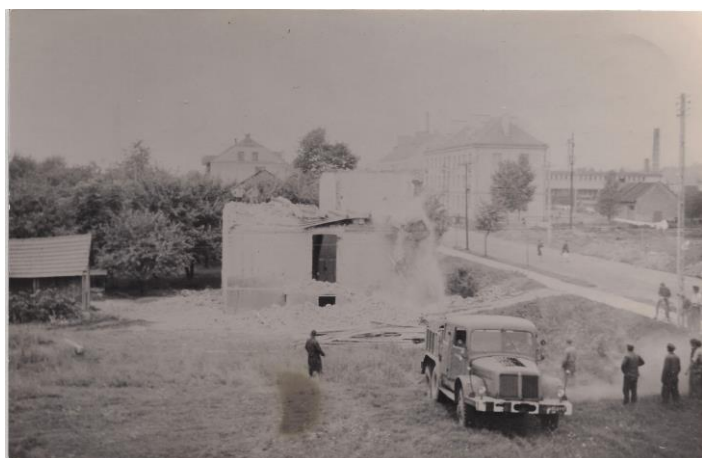
Fot. 22 Wyburzenie domu Bugnów rok 1966.
